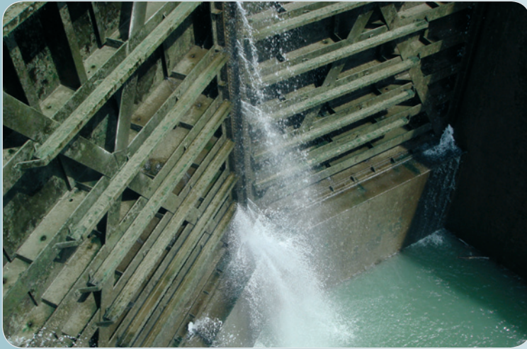
Porte d'écluse de Beauchastel hauteur 12 mètres (Rhône)
