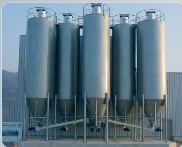
○ 6 Silos Ø 2500 mm capacité 50 m³ (CAMPENON)
