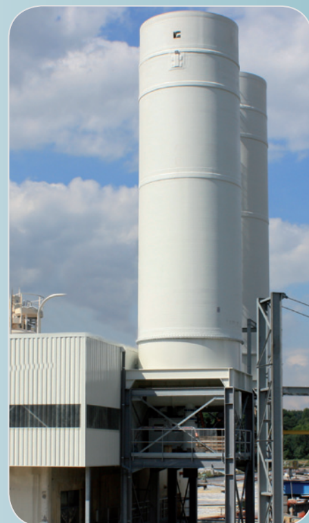
Silos jumeaux 2 x 240 m 3 avec extension du bâtiment (ADISSEO).
