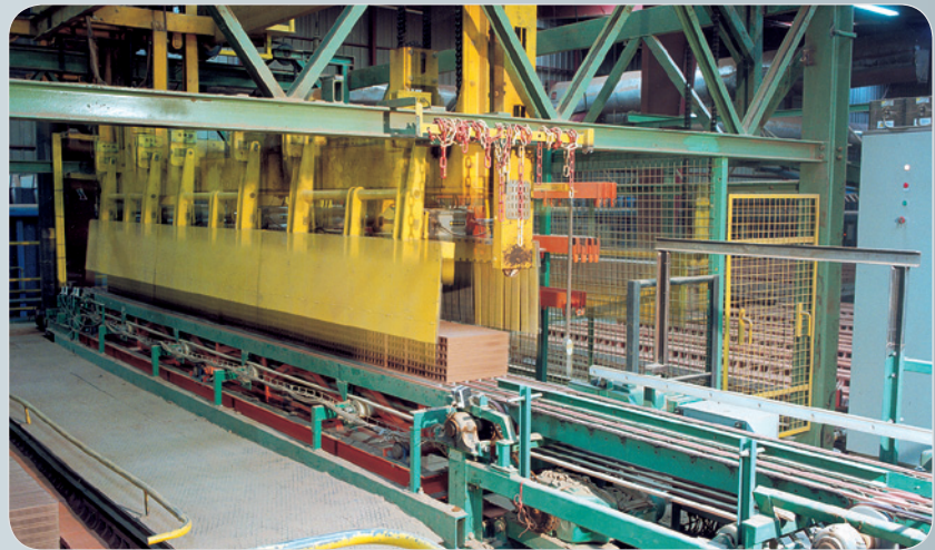
Convoyage et manutention de briques. (IMERYS STRUCTURE)
